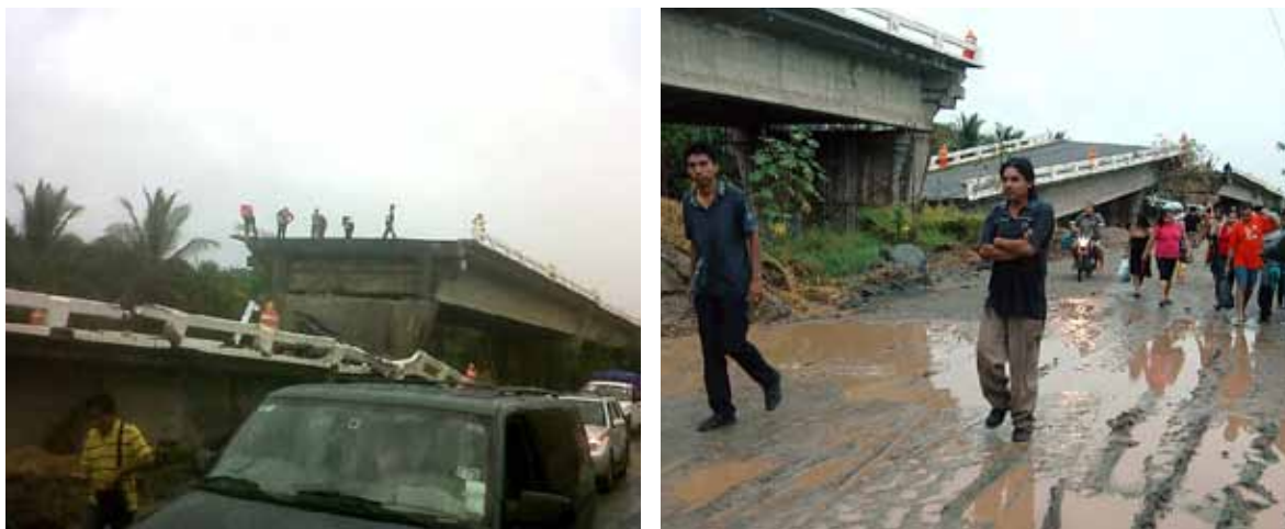
Figura 23. Colapso del puente “El Cuajilote” cerca de Tépán Guerrero debido al sismo de mayo de 2014 (Agustín y Trujillo 2014).
