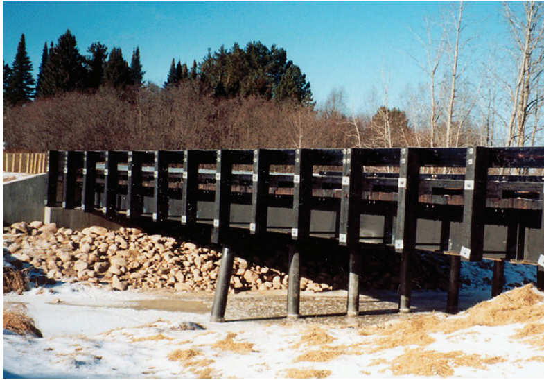
Figura 16. Superestructura de acero con cubierta de madera tratada.
