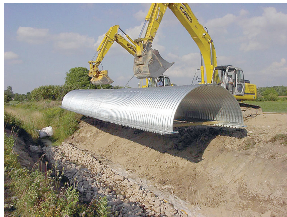
Maniobra en puente con lámina corrugada de acero
