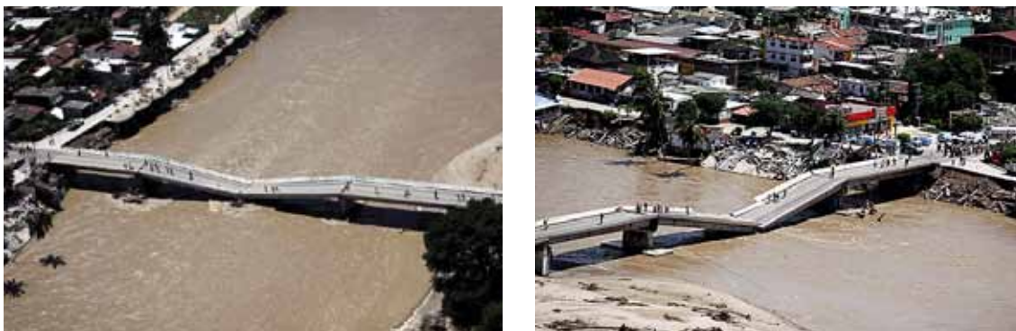
Figura 3. Colapso del puente “Coyuca 1” de concreto el 18 de septiembre del 2013 debido al paso del huracán Manuel (Xinhua 2013).
