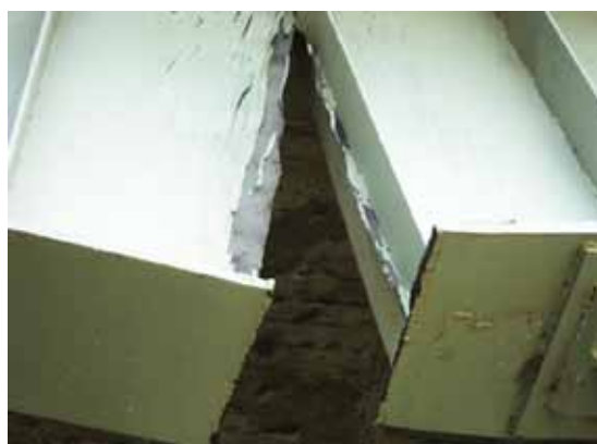
Acercamiento en la zona de fractura
