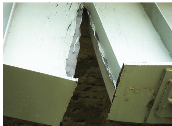
Acercamiento en la zona de fractura
