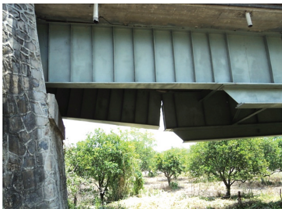
Vista lateral del puente
