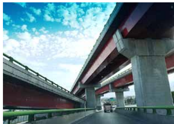
b) Vista de rampas de acceso
