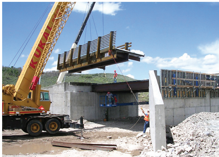
Figura 17. Colocación de puente.
