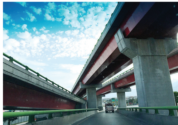
b) Vista de rampas de acceso
