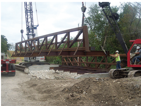
Maniobra en puente de vigas laminadas
