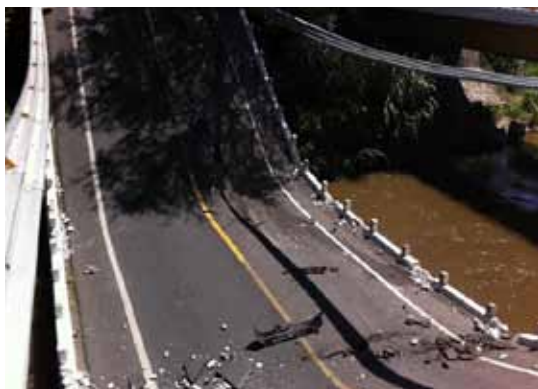
Vista general del puente
