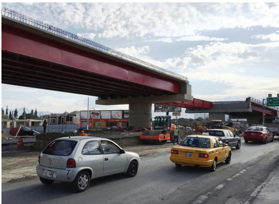
a) Vista de la construcción
