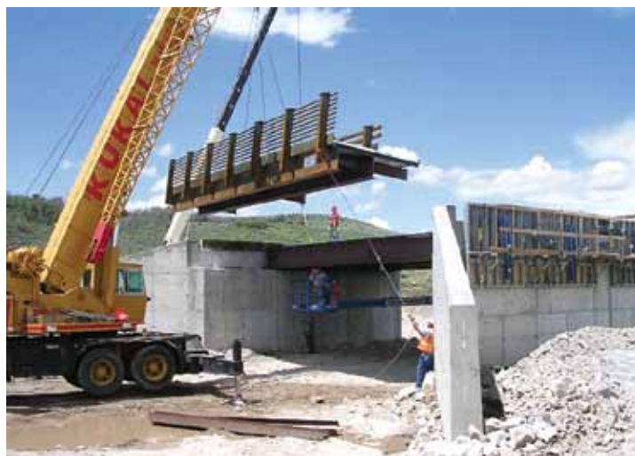
Figura 17. Colocación de puente.
