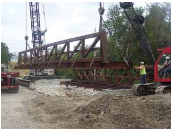
Maniobra en puente de vigas laminadas
