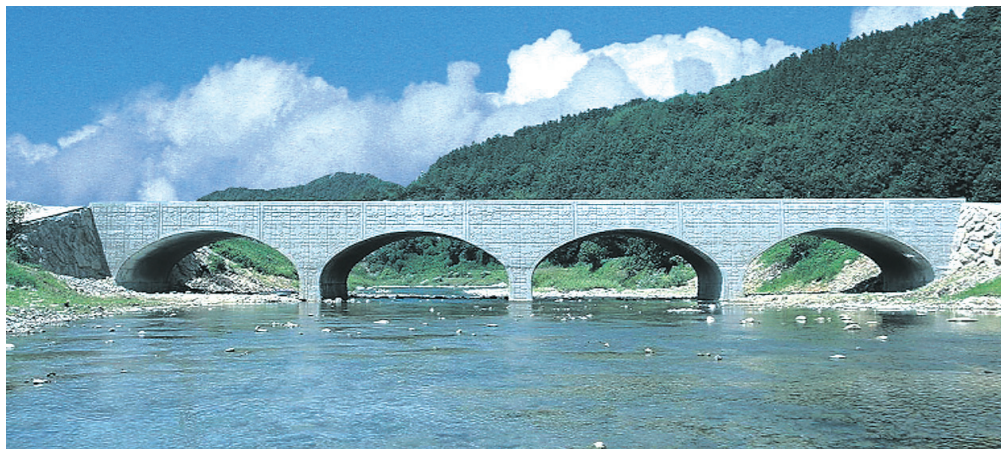
Figura 22. Puente con múltiples claros.
