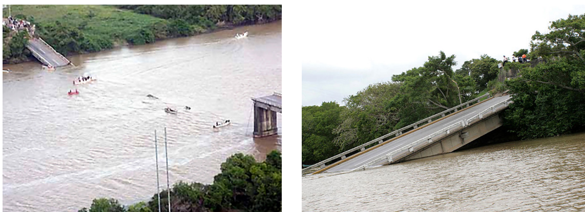
Figura 2. Colapso del puente “Tonalá” de concreto en carretera Coatzacoalcos-Villahermosa en julio de 2009 atribuido a socavación en dos pilas (Basilio 2009).
