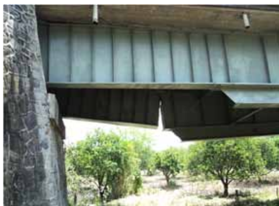
Vista lateral del puente
