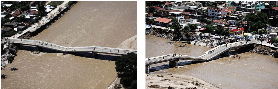
Figura 3. Colapso del puente “Coyuca 1” de concreto el 18 de septiembre del 2013 debido al paso del huracán Manuel (Xinhua 2013).
