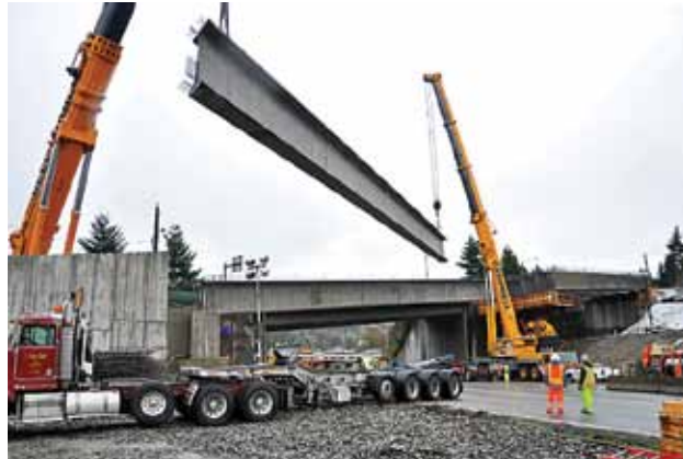
Figura 19. Colocación de trabe prefabricada de concreto armado (adaptada de Argos 2014).
