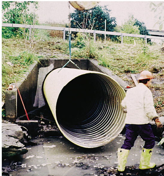
Figura 21. Alcantarilla de concreto reparada con tubos corrugados de acero.
