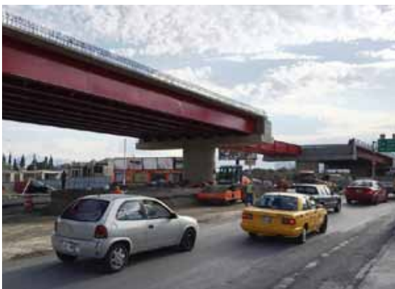
a) Vista de la construcción
